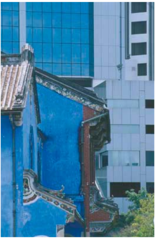
Penang – Le Palais Bleu Photo: Alberto Bali
